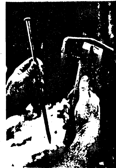
Ein Holzbrückennagel und ein Fäustel, zu benutzen für die sehr großen Bäume. Kleinere Nägel sind fein für den allgemeinen Gebrauch und können mit einem schweren Standardhammer eingehämmert werden.
