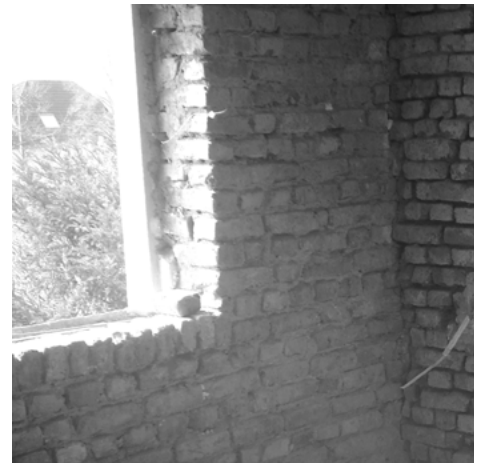
Doppelglasfenster einbauen, neu vermörteln...
