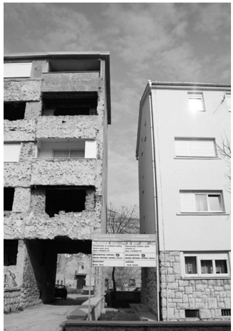
Wohnhäuser in Mostar (beide bewohnt).
