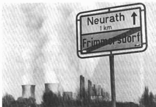
Die installierte TAV-Entschwefelungsanlage im Kraftwerk Neurath entspricht nicht mehr dem „Stand der Technik“
