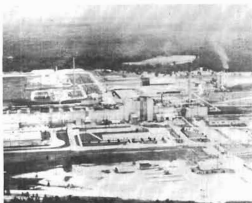
Militärische Wiederaufarbeitungsanlage der Savannah River Plant in South Carolina/USA
