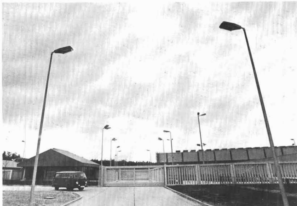
Schutz der Bevölkerung vor dem Fortschritt — Zwischenlager Gorleben vor der ersten Atommüll-Einlagerung im Sommer 1984.
