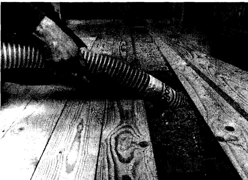
Foto: Weit verbreitet im biologischen Dämmstoffbereich sind Altpapierfasern. Sie werden in Decken und Dächer eingeblastet, d.h. sie benötigen eine zweiseitige Schalung. Auch Wände können so gedämmt werden. Um das Papier brandhemmend zu machen, werden Borverbindungen zugesetzt, deren Unbedenklichkeit für Umwelt und Gesundheit umstritten ist.
