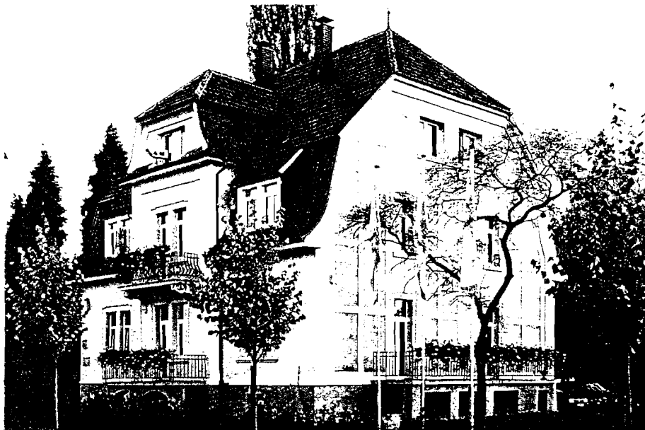
Abb. 3: Ansicht der sanierten Villa Tannheim mit TWD-Verbundsystem aus 10cm starken Kapillarplatten, Fläche 70m 2 , Fertigstellung 1995 /2/
