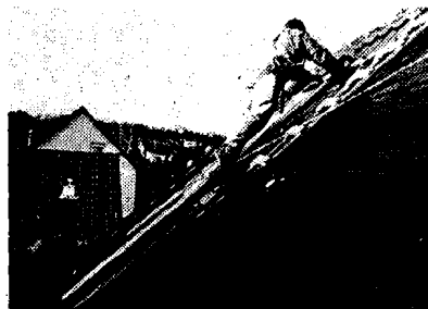
Der Kollektor des Umweltmodellhauses in Saasen wird montiert
