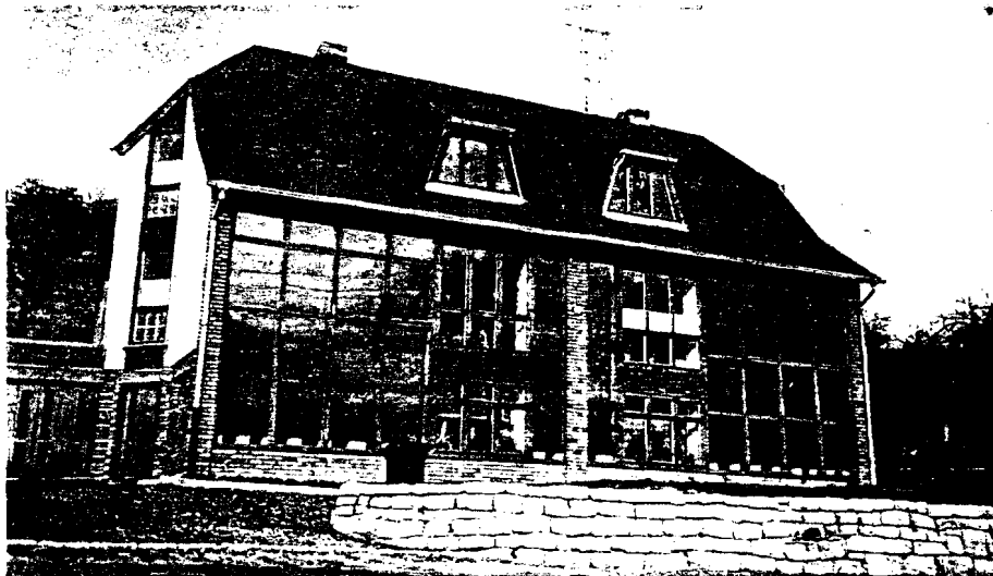
Abb. 4: Ansicht des 1994 mit ca. 50m 2 TWD sanierten Sonnenhauses Hopfgarten
