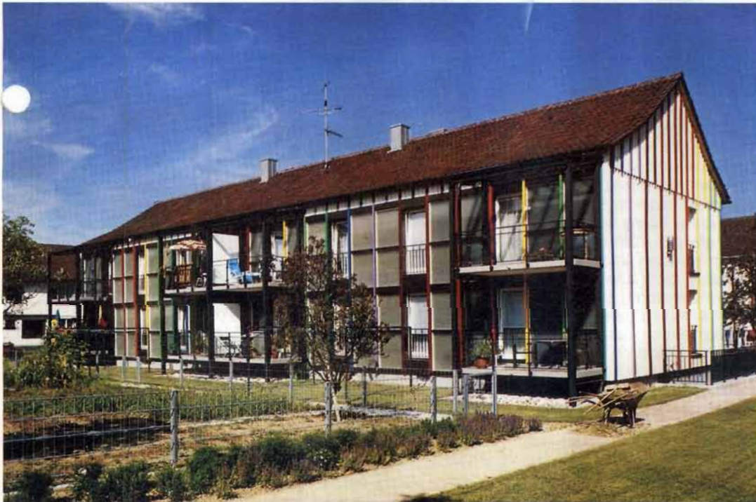
Modellhaus mit transparenter Wärmedämmung in Freiburg: Mit Niedrigenergiehäusern und optimaler Wärmedämmung läßt sich der Energiebedarf für Gebäudeheizung bis zu 85 Prozent reduzieren; damit natürlich auch die spezifische Kohlendioxidemission.
